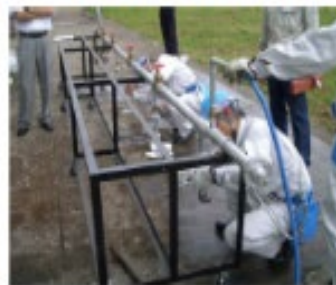
ドレン弁詰まり貫通体験
